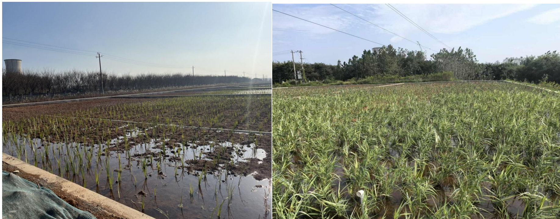
附图 6-1 项目现状图（潜流湿地）
