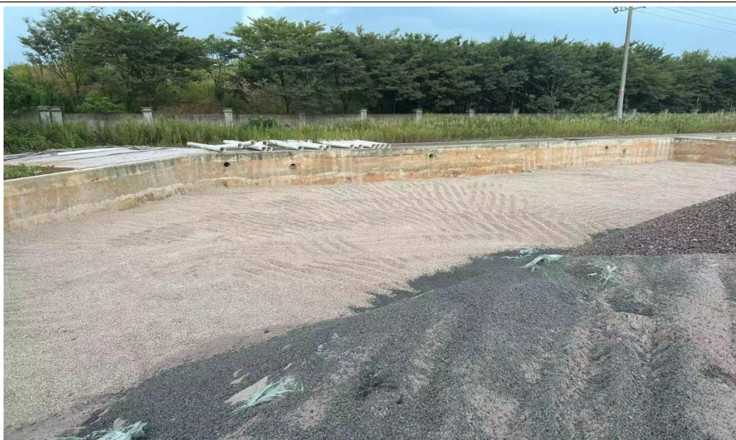
图4-4 施工时周边围挡
