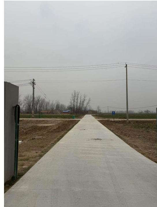
进场道路硬化
