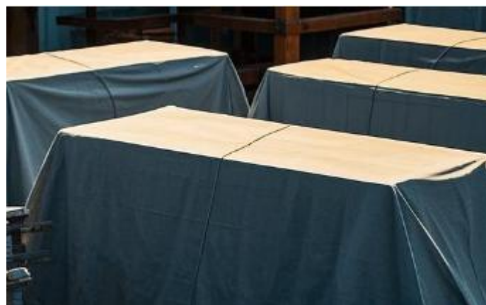
施工材料苫盖
