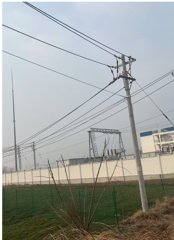
塔基生态恢复情况（周边已恢复用地性质）
