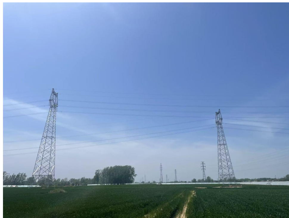
临时道路恢复
