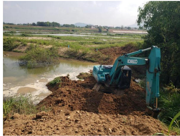
姚家二闸围堰施工
