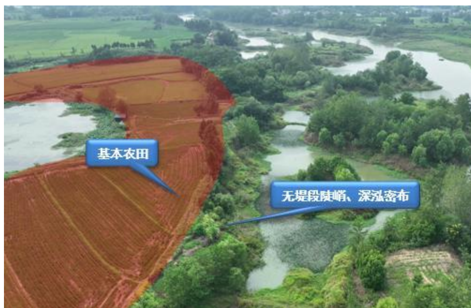
图 2-7 保丰圩段堤防现状问题 3
