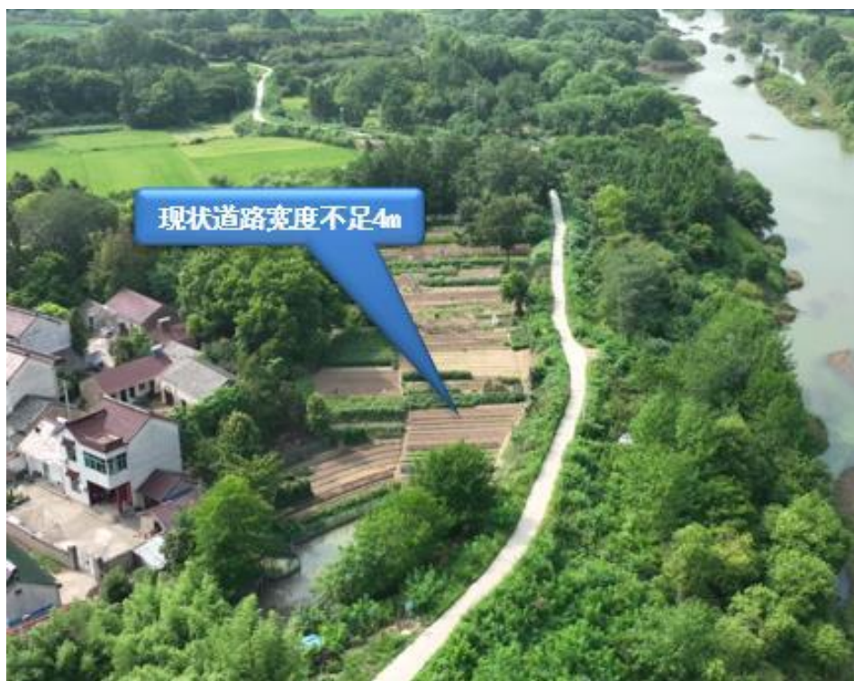
图 2-5 保丰圩段堤防现状问题 1
