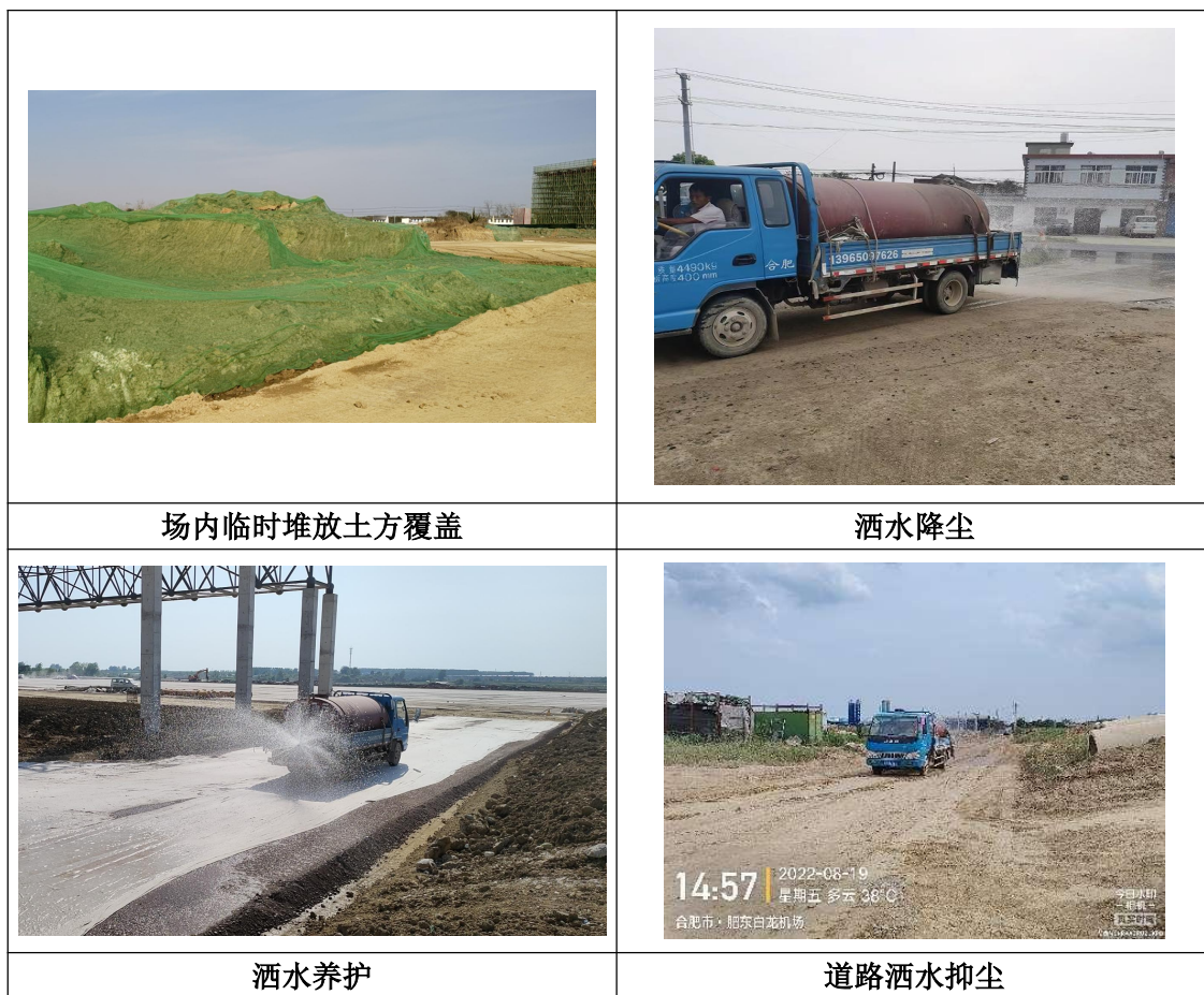
图 4.1-7 本项目施工期废气处理措施现场照片
