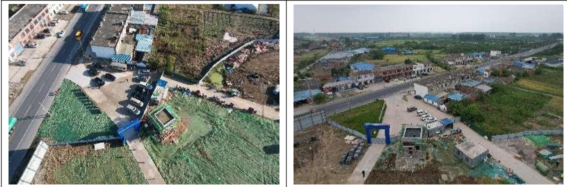
施工期生活垃圾堆放及覆盖
