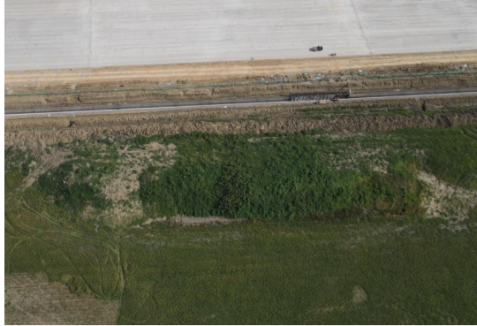
临时堆土区 2024 年 4 月影像
