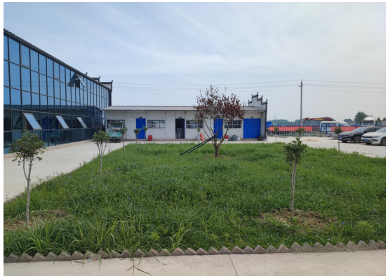
施工生产生活区临时绿化
