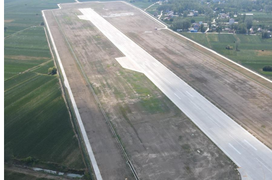
临时堆土区 2025 年 7 月影像
