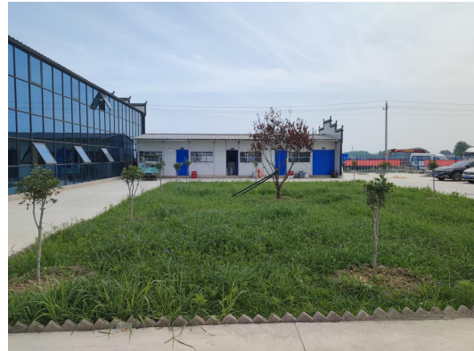
施工生产生活区临时绿化
