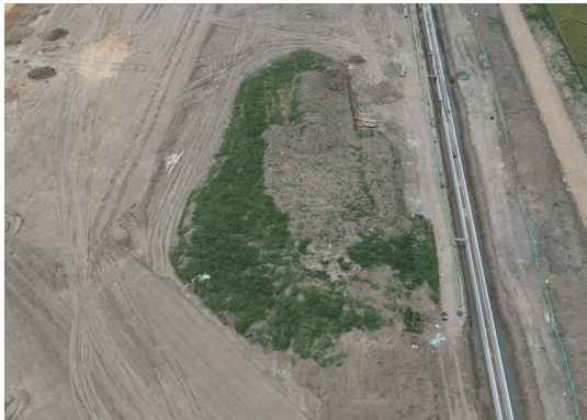
临时堆土场区撒播草籽
