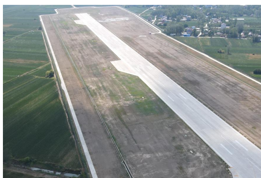
临时堆土区 2025 年 7 月影像
