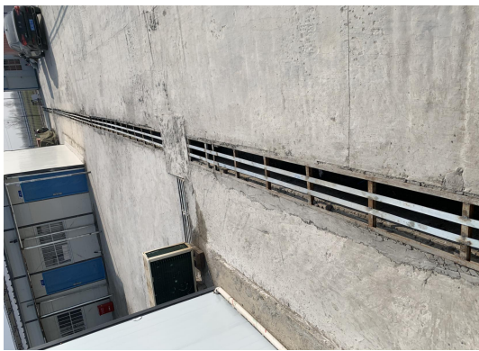
施工生产生活区临时排水
