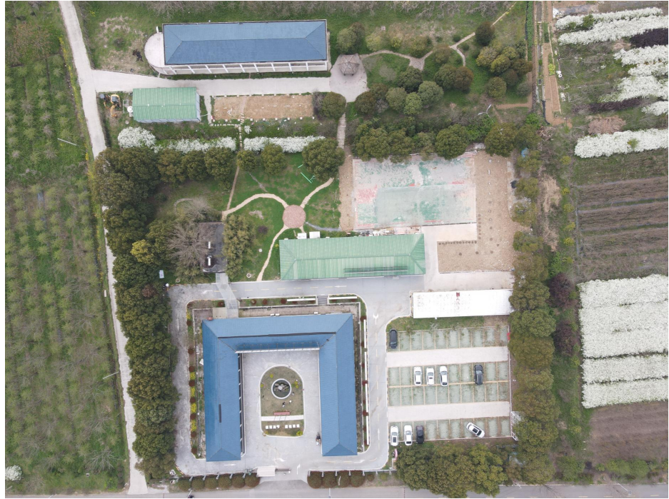
施工场地办公区、生活区道路硬化
