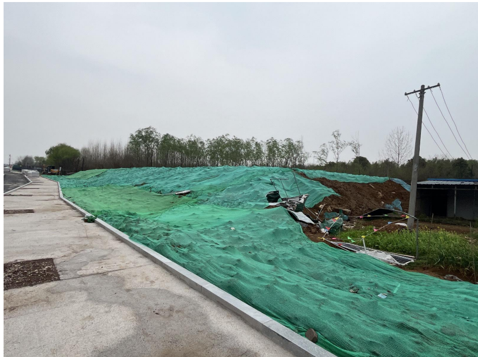
施工区行车道路硬化、裸土覆盖
