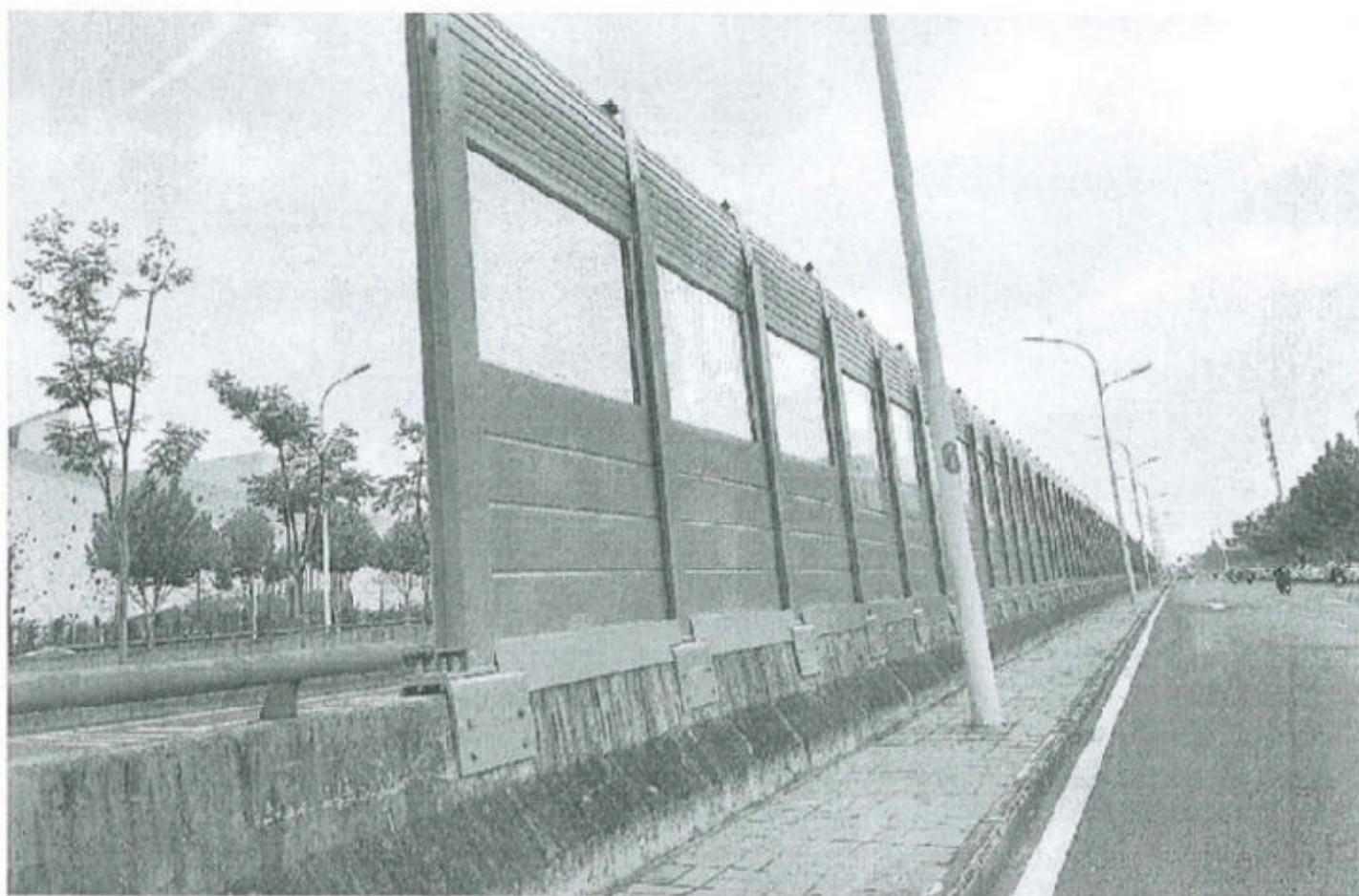
西侧下穿声屏障安装后图片
