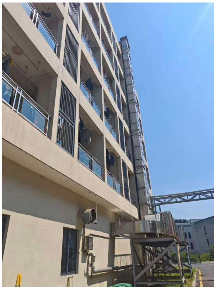
食堂油烟废气排气筒 DA008
